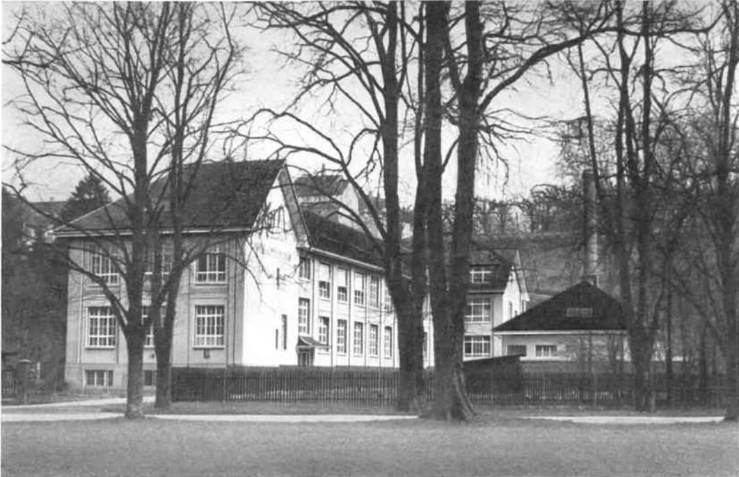
Fabrikanlage an der Schachenallee
