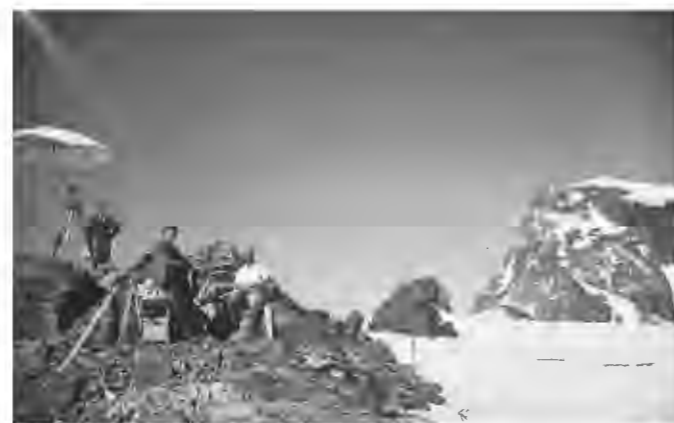
Frutigen-Ost, Aufnahmen mit dem Phototheodolit Wild für die Stereophotogrammetrie, 1925. Foto © swisstopo, Bildsammlung.
