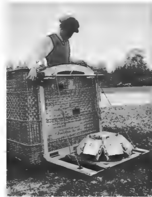
Chef-Ingenieur Kämmerer mit dem am Ballonkorb montierten Kameragestell, 1913. Foto: Ingenieur Johann Ganz © swisstopo, Bildsammlung.
